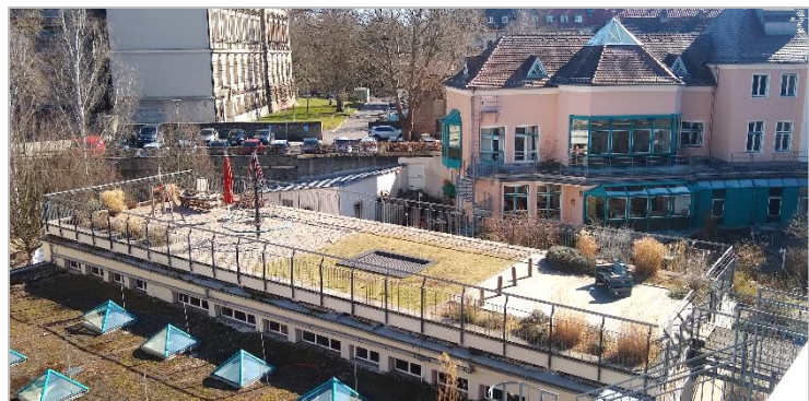
Ein Dachspielplatz nahe der Regierung von Unterfranken. Hier wird eine Halle gleich doppelt genutzt – unter anderem für einen Kindergarten. Foto: Johannes Hardenacke
